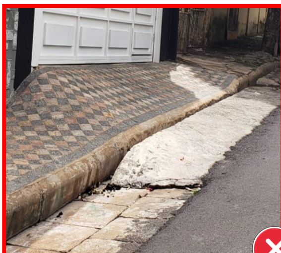
Rampas em via pública
